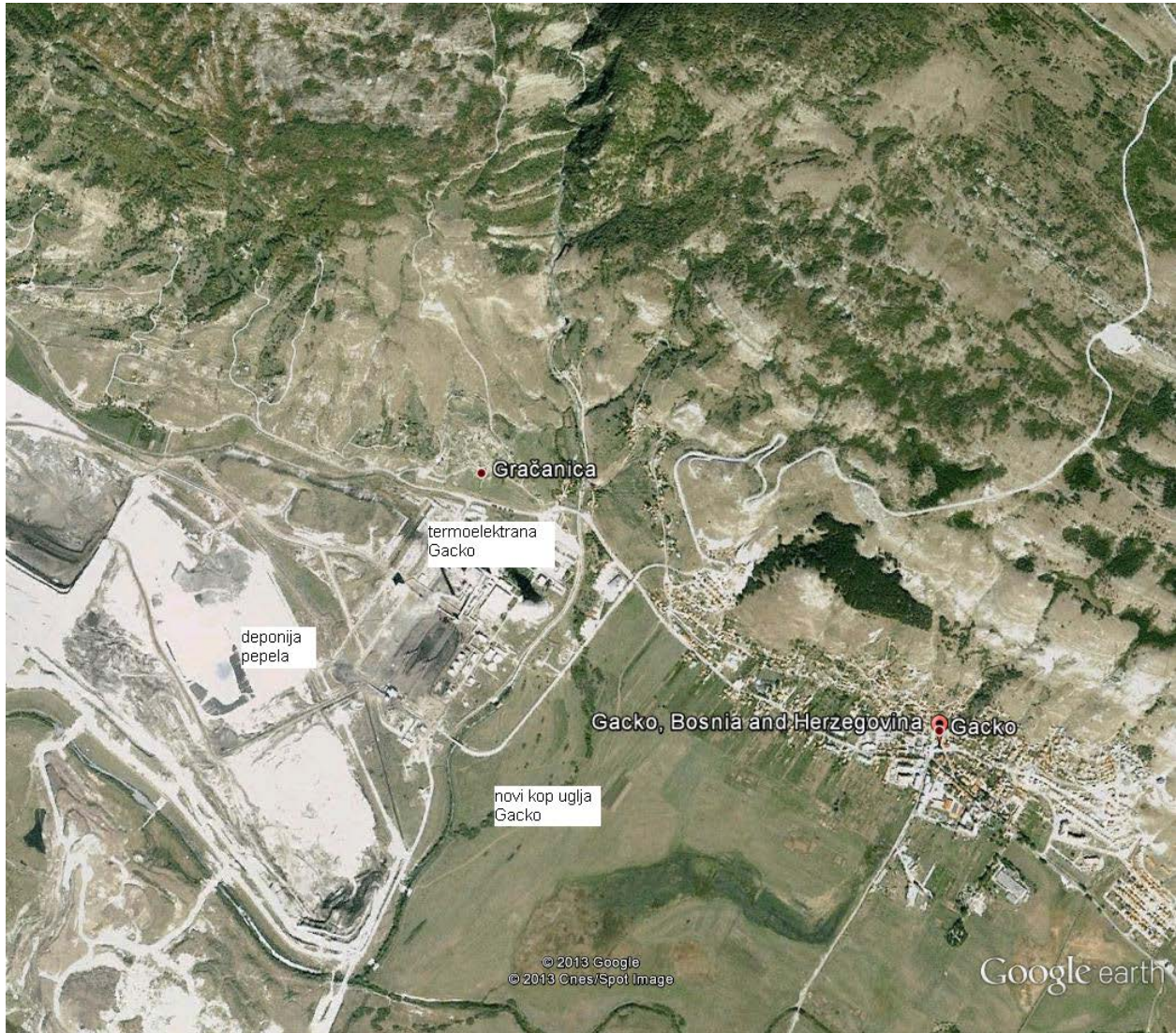
Слика 1: Сателитски снимак ширег подручја града Гацка са локацијом индустријске зоне Рудника и ТЕ Гацко
